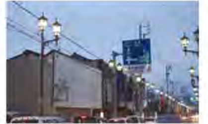
LED化された街路灯
